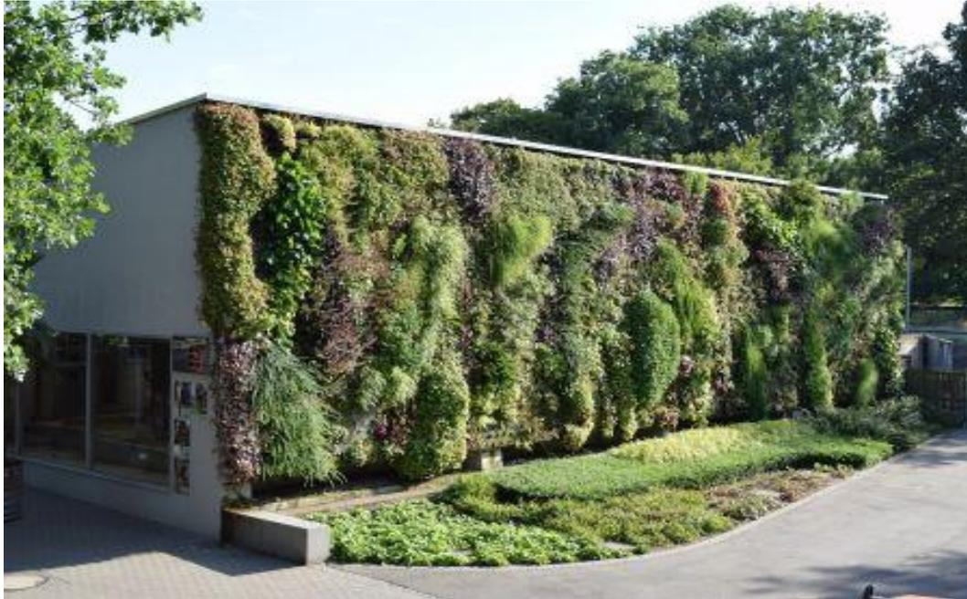
Abbildung 3: Ein Beispiel für eine begrünte Fassade. Dadurch wird sowohl die Umgebungstemperatur, sowie die Temperatur im Inneren des Gebäudes positiv beeinflusst (Quelle: Chemnitz o.J.).
